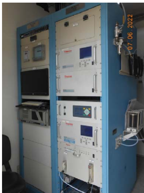
รูปที่ 3 ระบบตรวจวัดคุณภาพอากาศที่ระบายจากปล่องระบายอย่างต่อเนื่อง (CEMs)
