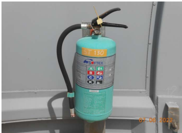
รูปที่ 24 การติดตั้งเครื่องดับเพลิงชนิดมือถือ ตามมาตรฐาน NFPA
