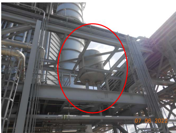
รูปที่ 11 อุปกรณ์ลดเสียง Duct Silencer บริเวณจุดระบายไอน้ำจาก HRSG
