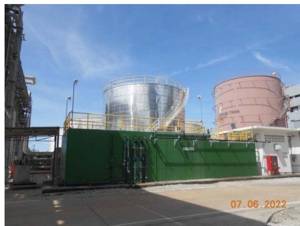
รูปที่ 5 จุดรวบรวมน้ำทิ้งจากการอุปโภค-บริโภค เข้าสู่ถังบำบัดน้ำเสียก่อนระบายลงสู่รางระบายสาธารณะ
