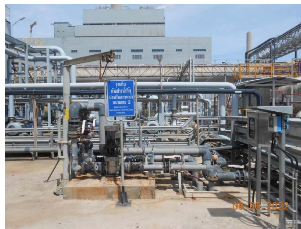
รูปที่ 7 ระบบปรับสภาพน้ำให้เป็นกลาง
